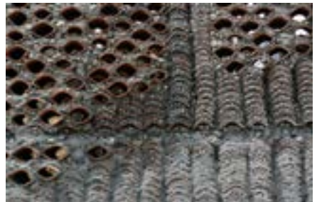
Mampostería de teja armada Fotografía: Iván Jiménez
